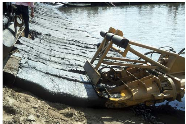
Bild 2: Tonbahnen-Verlegung am DEK, Los 15
