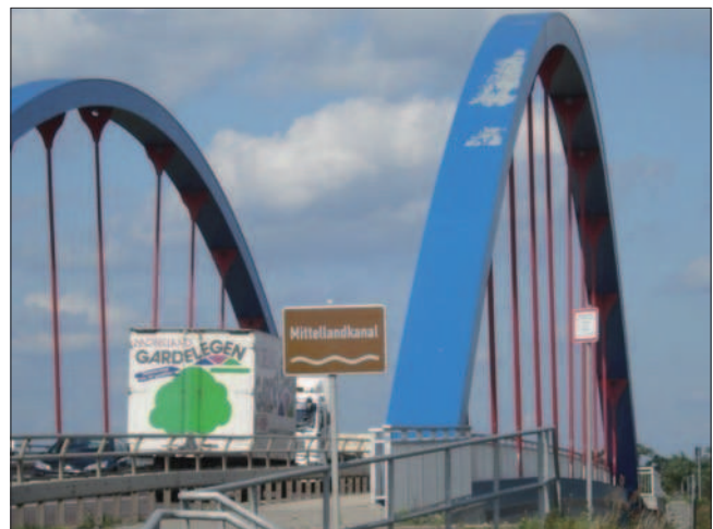
Bild 1: Beginnender Enthftungsschaden bei Blatt 87 – blaue DB löst sich ab
